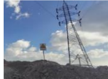
Cancha de desmote cable Eléctrico a 18 metros de la base mas elevada
