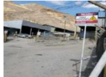
Ingreso taller Mantto Mecánico señalización de tensión y altura instalada
