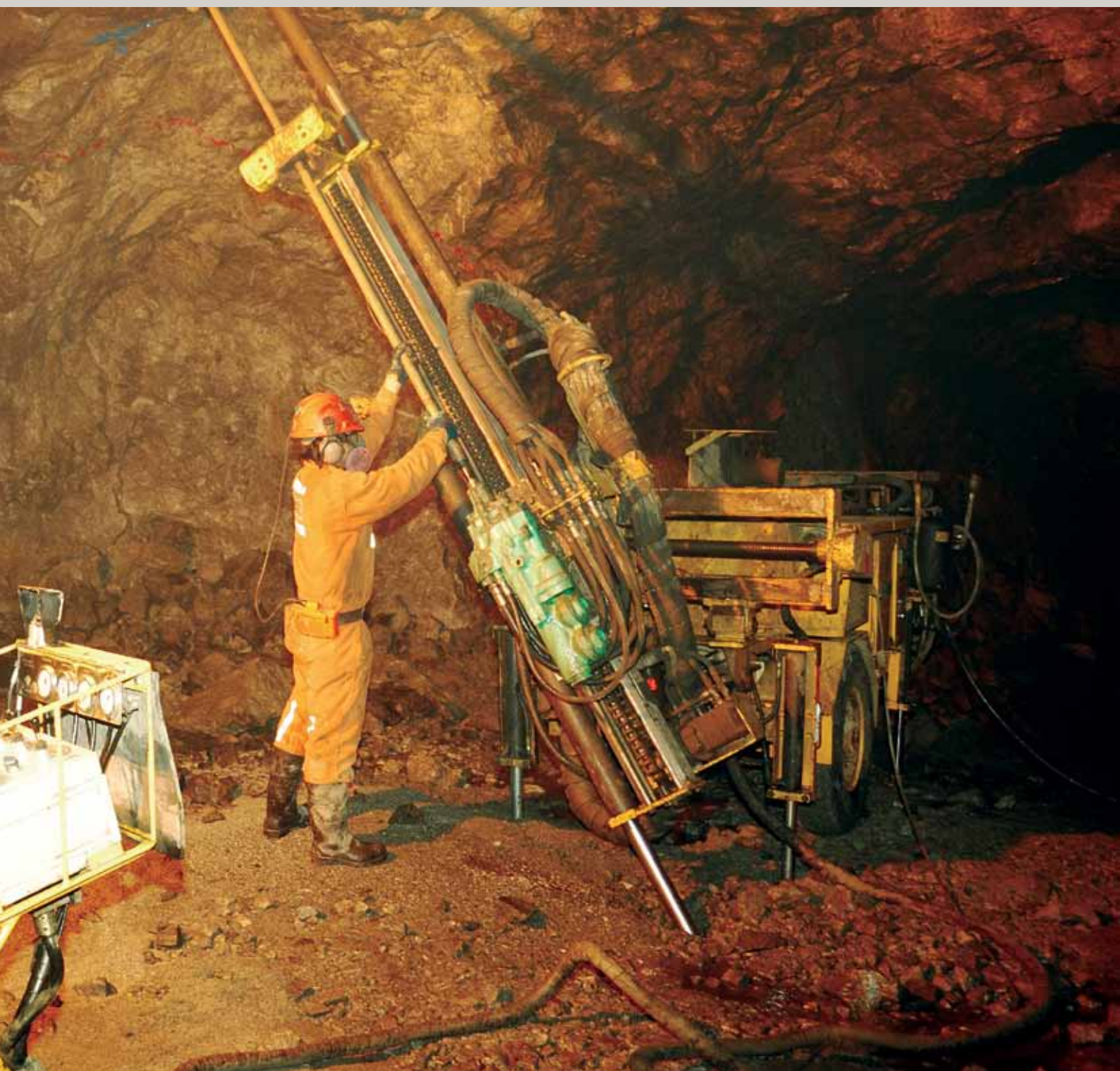
Perforación Diamantina en interior mina - Vinchos
